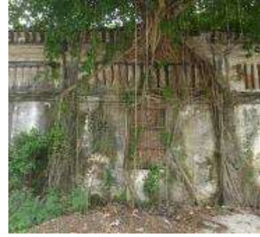
รูปที่ 8. ผนังด้านทิศใต้ มีต้นไทรขนาดใหญ่ขึ้นที่แนวผนัง
