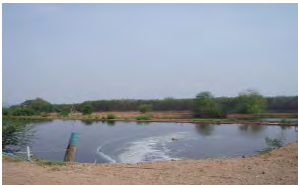
ภาพที่ 4 บ่อบำบัดน้ำเสียแบบตกตะกอน
