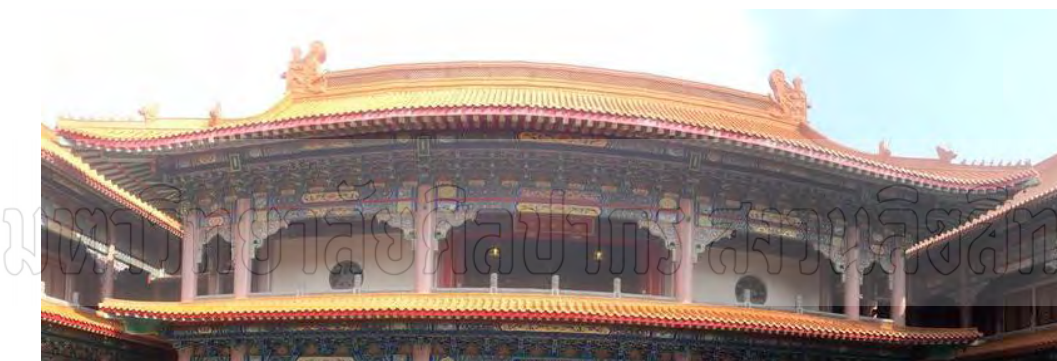
(ภาพที่ 34) หลังคาอาคาร 4 ชั้น วัดเล่งเน่ยยี่ 2
