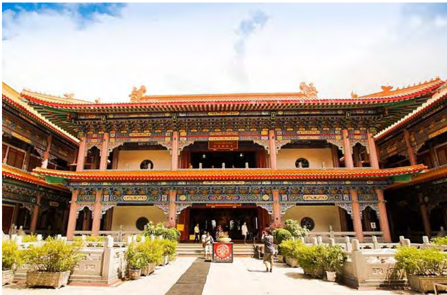
(ภาพที่ 14) อาคาร 4 ชั้น
