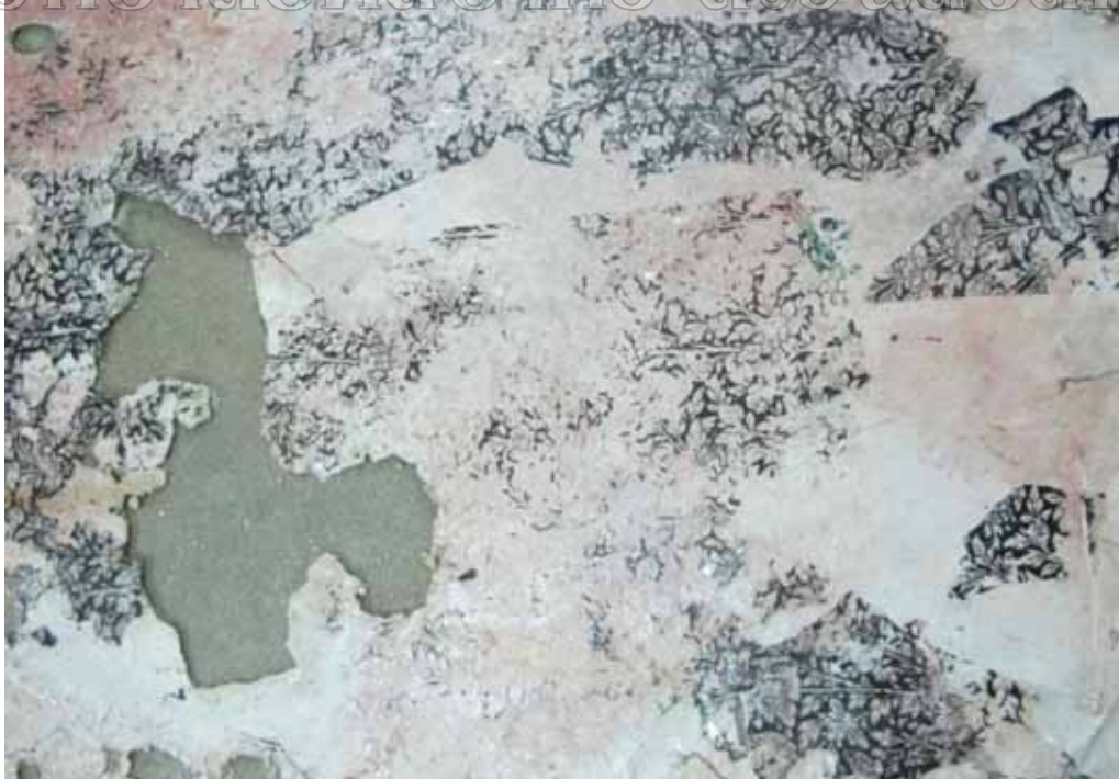
ภาพที่ 28 : ภาพร่องรอยที่หลุดร่อนของพื้นปูนซีเมนต์
