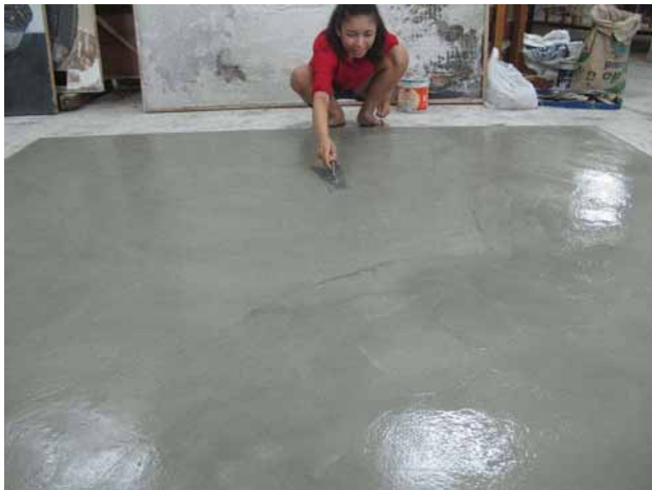
ภาพที่ 26 : ขั้นตอนการฉาบปูนซีเมนต์
